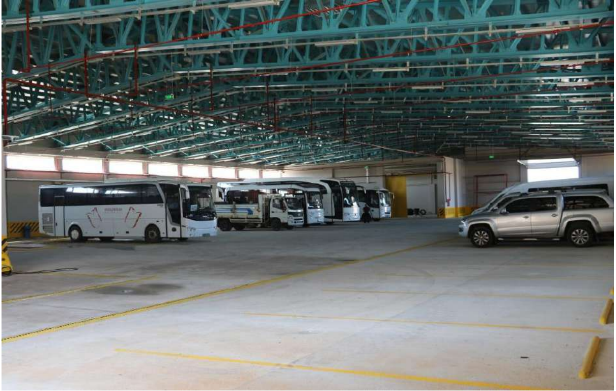
Resim 4. Hangar İç Görünüm
