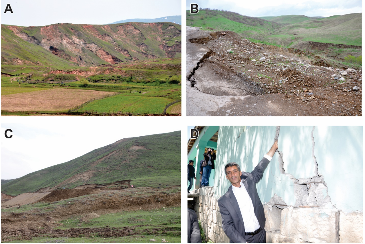
Şekil 4 : İlkbahar döneminde (2014-2015) gelişen sığ ve aktif heyelanlara örnekler. (A) Kızılağaç beldesinde gelişmiş sığ kaymalar, (B) Varto yolu üzerinde gelişen heyelana bağlı yolda oluşan deformasyon, (C) Şahinler Köyü mevkiinde yolda gelişen sığ bir kayma, (D) Ağartı köyünde 2014 yılında gelişen heyelana bağlı olarak oluşan yapı hasarları.
