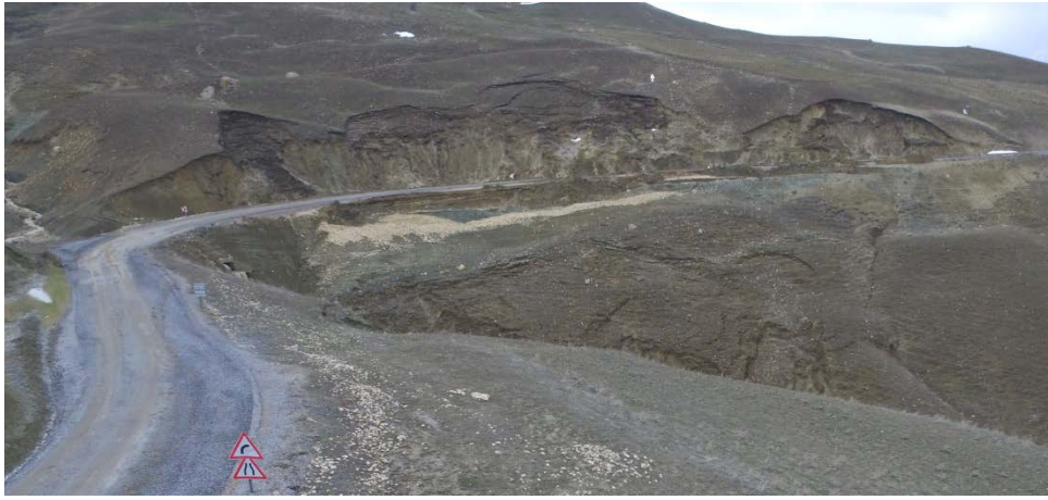
Resim 2: Sarıdal yolunu da etkileyen yağışlarla tetiklenen sığ kayma şeklinde ki heyelanlar.
